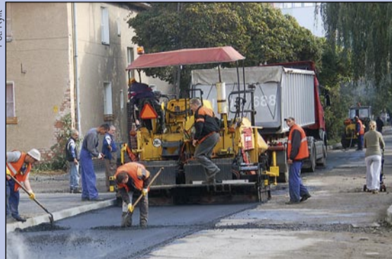
Drogowcy pracowali przy remoncie nawierzchni ulic na osiedlu Orle
