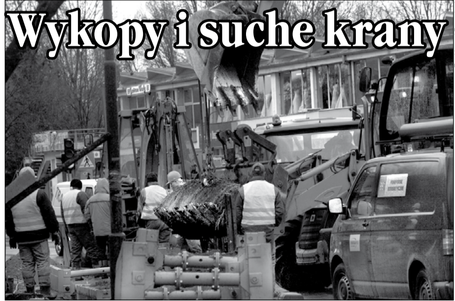
Prace przy ul. Różyckiego utrudniły ruch w centrum Zabobrza
