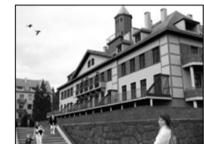
Od 3.700zł/m2 netto Osiedle Sudeckie Do sprzedaży mieszkania developerskie o pow. od 34 do 88 m2 z balkonami, również dwupoziomowe.
