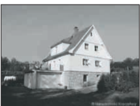
550.000 - 7km od centrum Dwa domy energooszczędne za 550.000 i 620.000, pow. 208m2, 5-pok, dz. 1030m2
